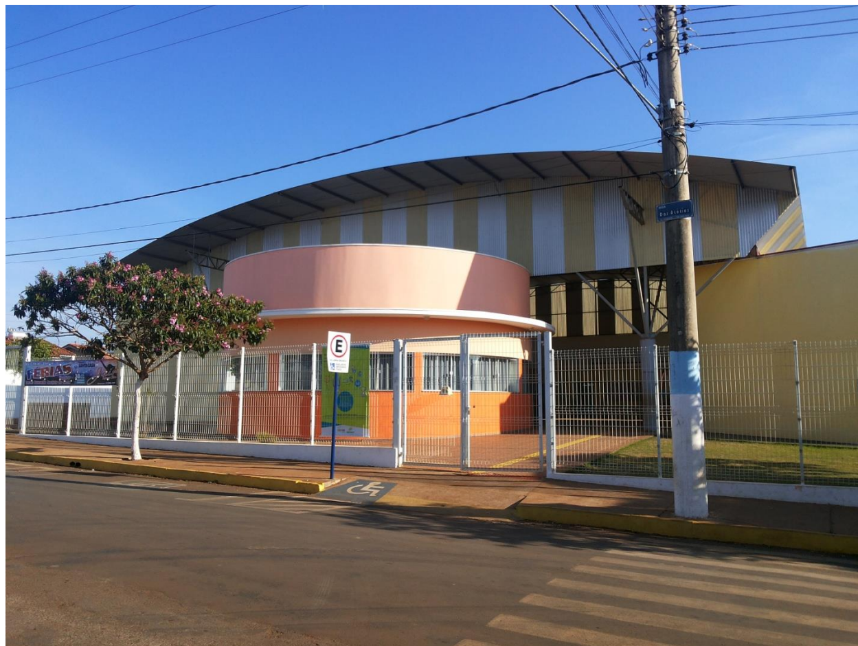
Figura 01 – Fachada da Faculdade – Ruas das Acácias, 110 - Taguaí
